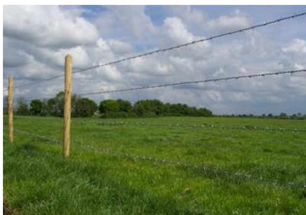
Exemples de clôtures perméables pour la petite faune (@Ecosphère)
